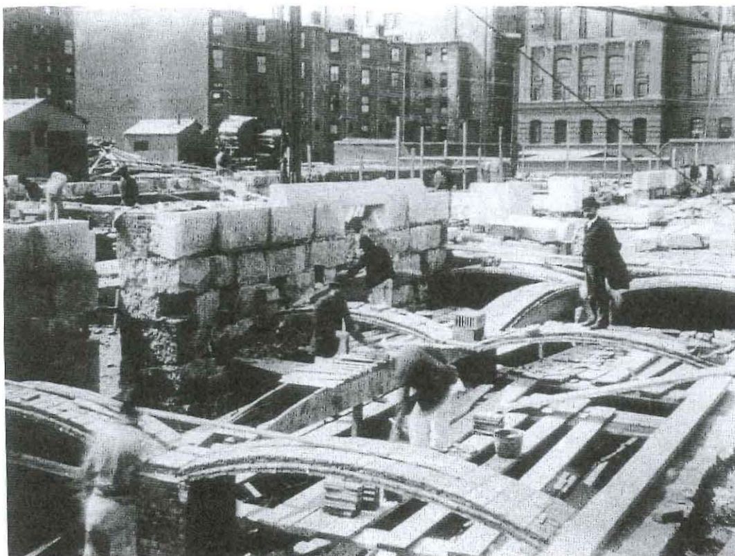
Figura 36 – Guastavino cammina sopra archi di tabicada appena costruiti
