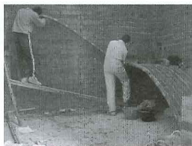
Figura 37 e 38 – Operai a lavoro per la costruzione di una cupola e di una scala a montacaballo, entrambe realizzate con la tecnica tabicada
