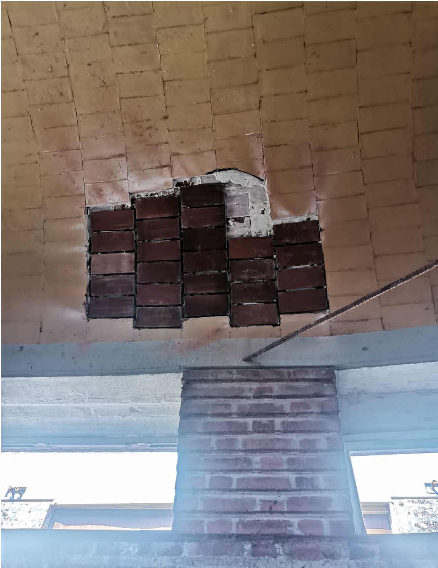
Img 3. Área de colocación de rasillas con el mortero de fraguado rápido en el intradós
