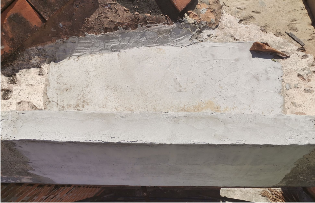
Img 1. Impermeabilizante aplicado en la canal pluvial.
