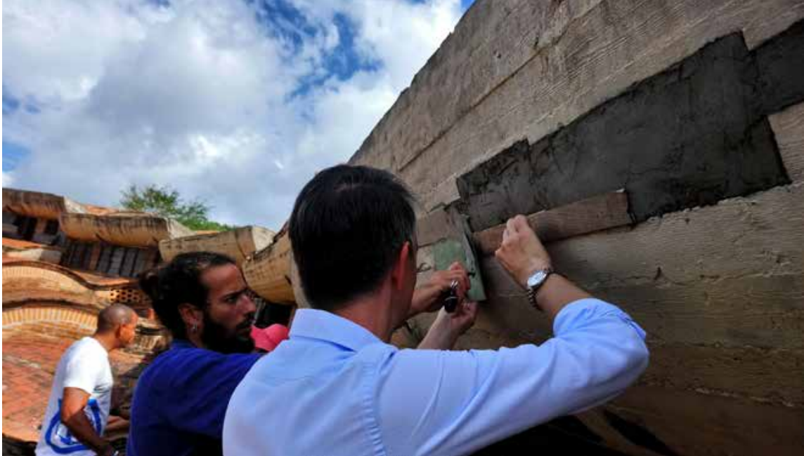
Figura 1: Aplicazione della finitura PLANITOP FINE FINISH Mapei
