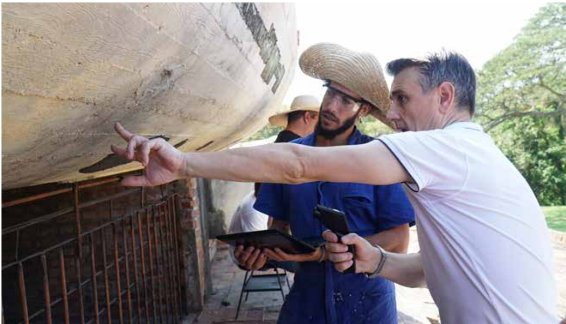
Figura 11: Rilevamento della temperatura superficiale
