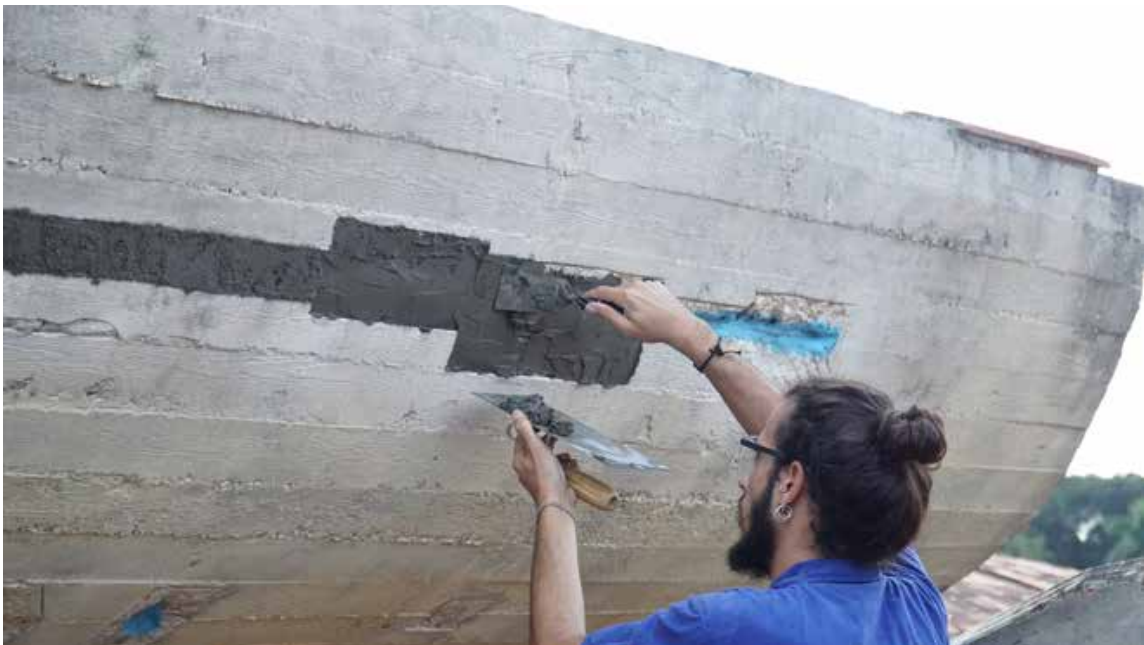
Figura 4: Applicazione di Mapegrout T60 Mapei (seconda mano)
