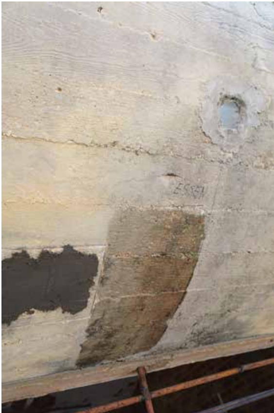
Figura 16: Applicazione del biocida essenzio su calcestruzzo già sottoposto a pulitura mediante sabbatura.
