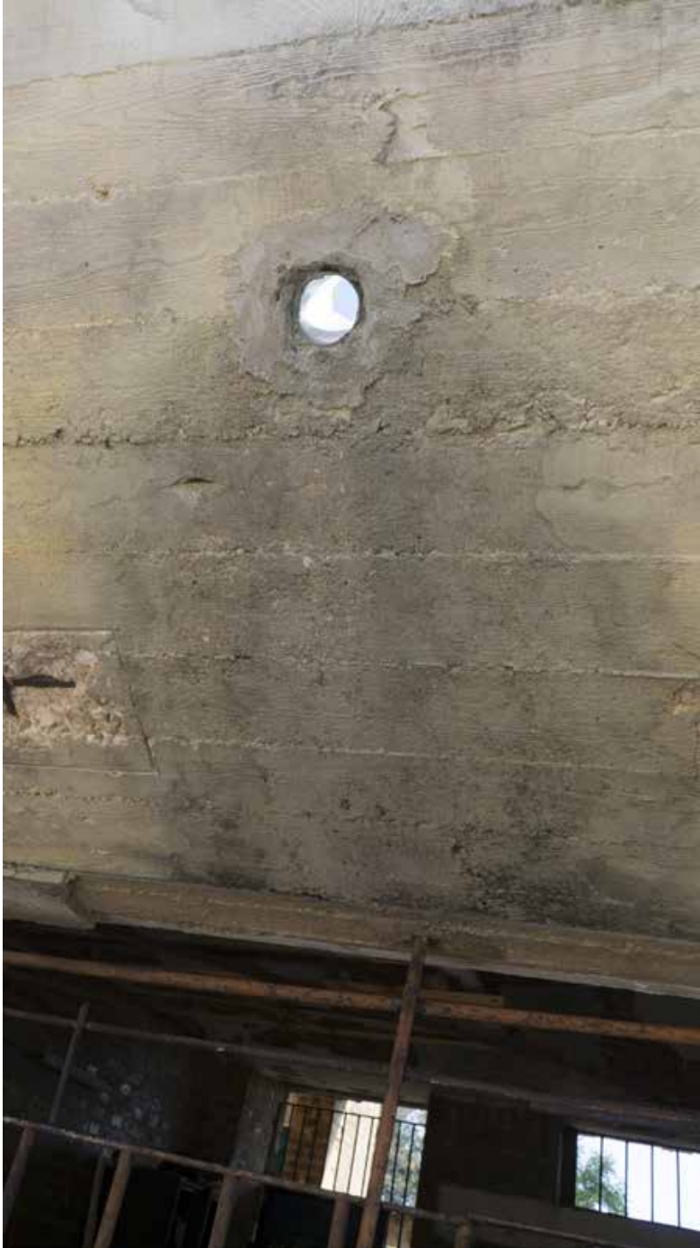
Figura 6: Risultato della pulitura del colaticcio e delle patine biologiche
