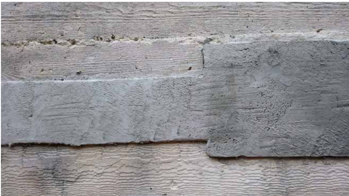
Figura 2: Risultato dell'applicazione in sovrasquadro della finitura PLANITOP FINE FINISH Mapei senza COLORITE.
