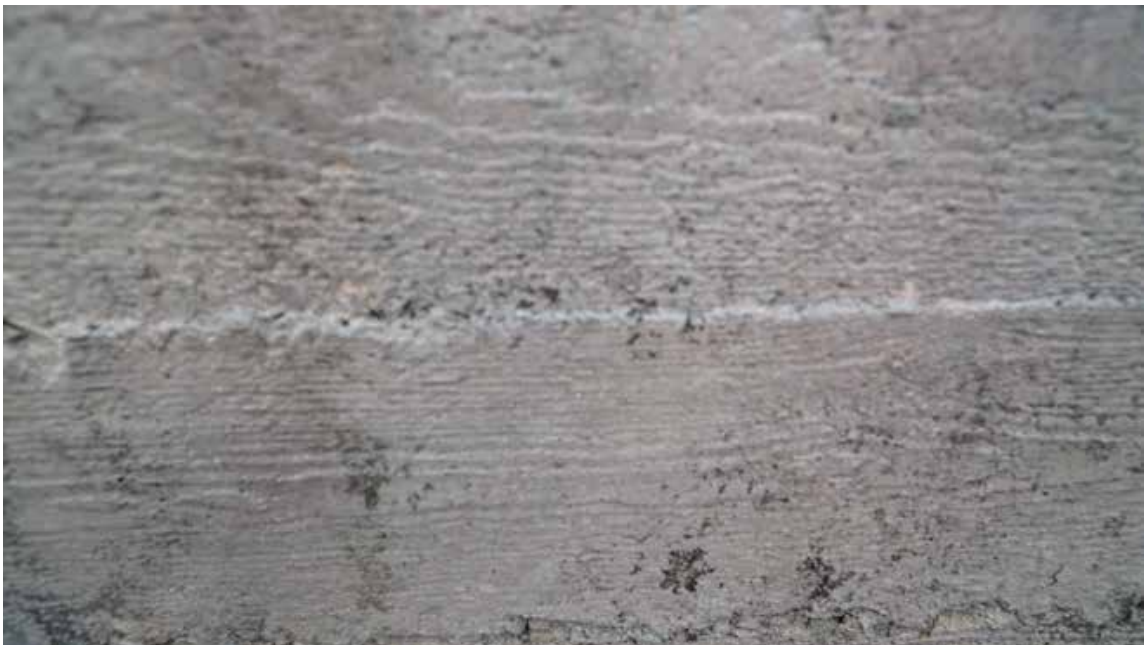
Figura 15: Resultados de la pulitura mediante sabbatura
