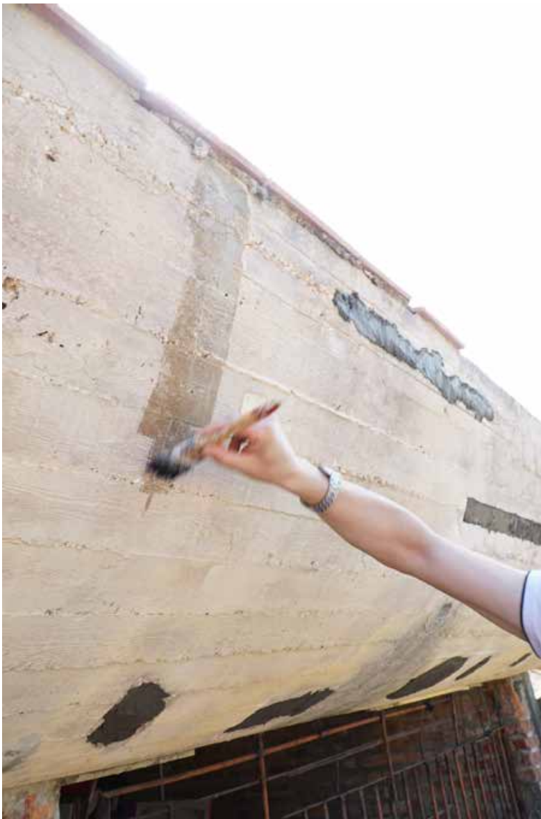
Figura 8: Applicazione protettivo impermeabilizzante I-Pro- tect AS IBIX biocare
