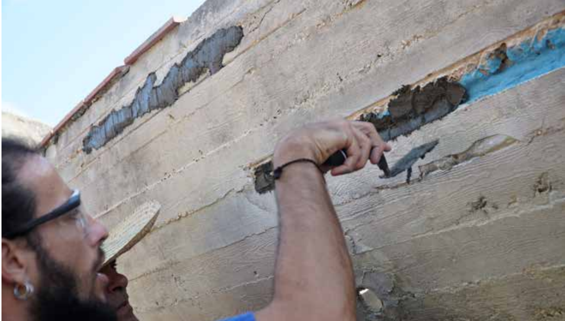
Figura 3: Applicazione di Mapegrout T60 Mapei (prima mano)
