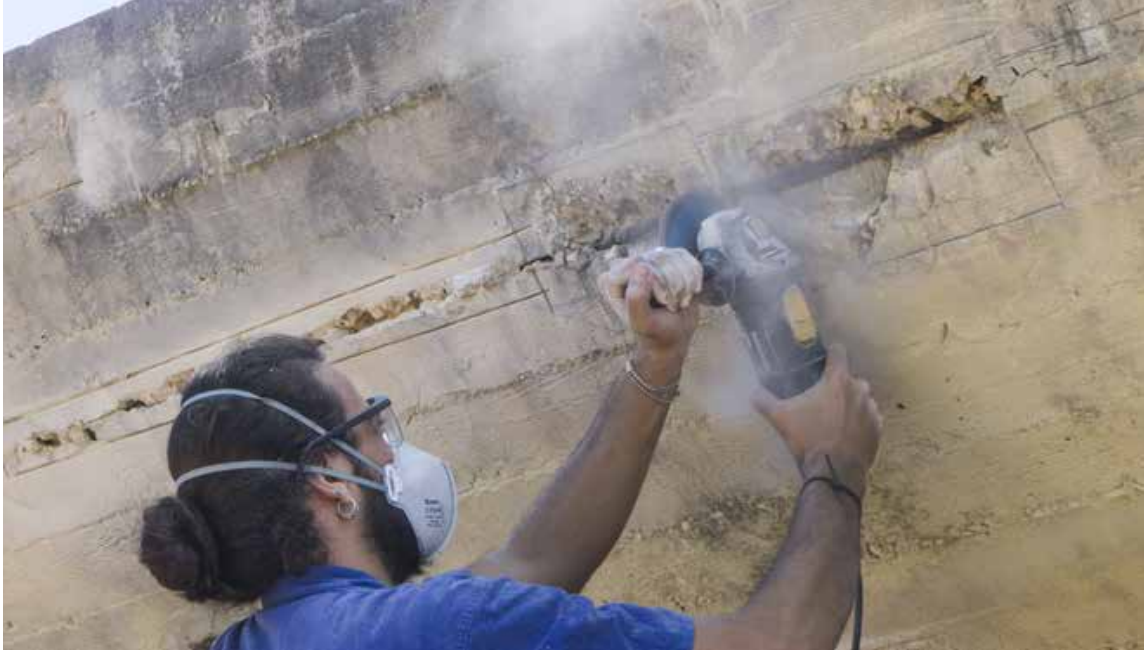
Figura 7: Creazione di scassi di vare forme geometriche in corrispondenza dei ferri scoperti
