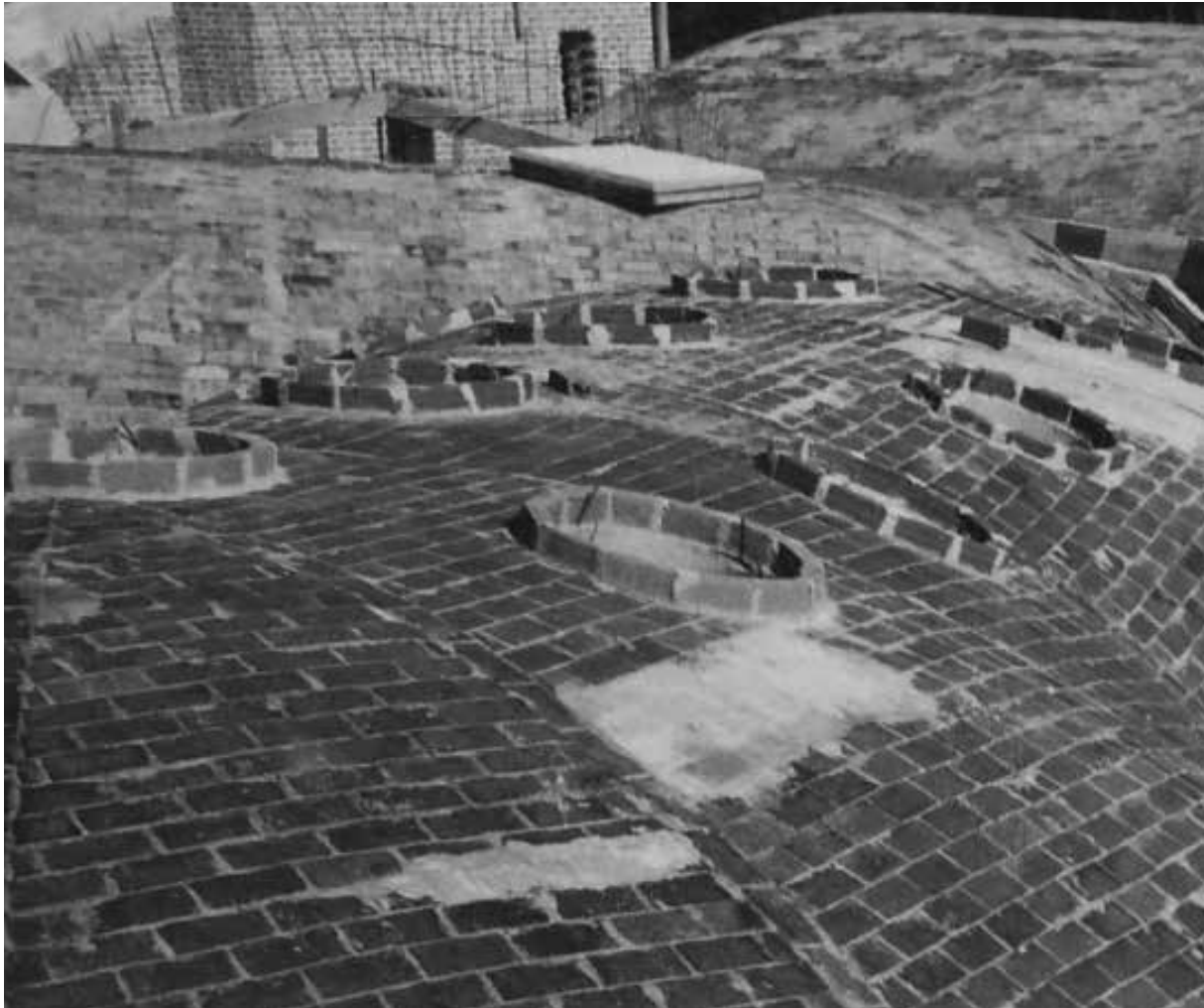
Figura 8 | Fotografía histórica de las fases de construcción con sello del Ministerio de la Construcción (detalle). Vista de los tragaluces de la bóveda del bloque 9, Archivo Gottardi, 1965.
