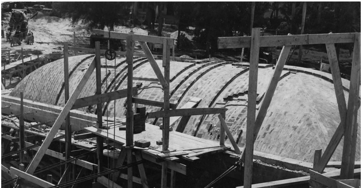
Figura 5 | Fotos históricas de las fases de construcción. En el tercer plano las costillas o guías de la bóveda. Respectivamente la primera y la quinta cimbra comenzando de izquierda a derecha, parecen estar dispuestas en pares, sugiriendo un encofrado. En segundo plano, en la bóveda por completar, se observa la presencia de hileras de ladrillos, dispuestas para crear un arco, aún visibles hoy en día en el extradós. Archivo Gottardi, fecha n.d.
