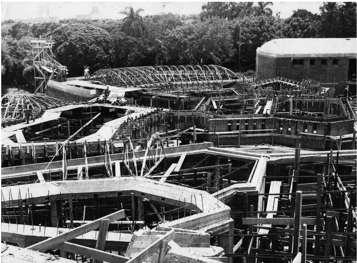
Figura 9 | Fotos históricas de las fases de construcción. Vista desde el tejado del bloque 11 orientada hacia el bloque 1. Archivo Gottardi, fecha n.d.
