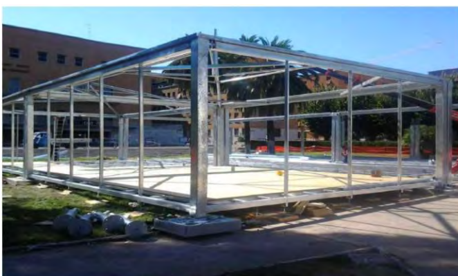
Figura 14 - Esempio struttura prefabbricata
