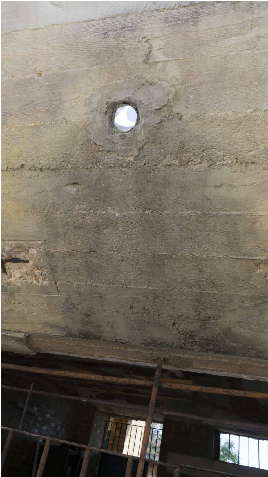
Figura 6 | Resultado de la limpieza de los lixiviados y pátinas biológicas.
