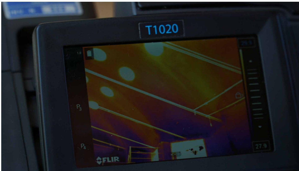
Figura 7 | Imagen termográfica en el BLOQUE 11. Destaca la presencia de algunos elementos “tipo costilla” tangentes a los lucernarios.
