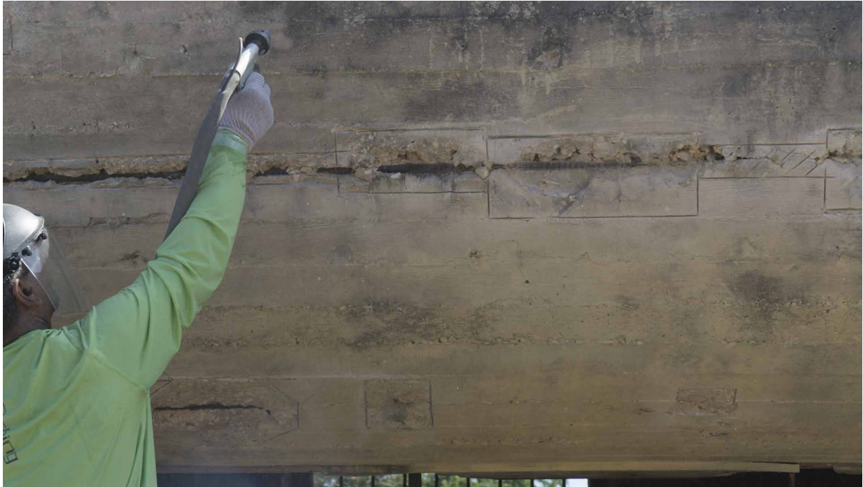
Figura 4 | Limpieza de lixiviados y pátinas biológicas.
