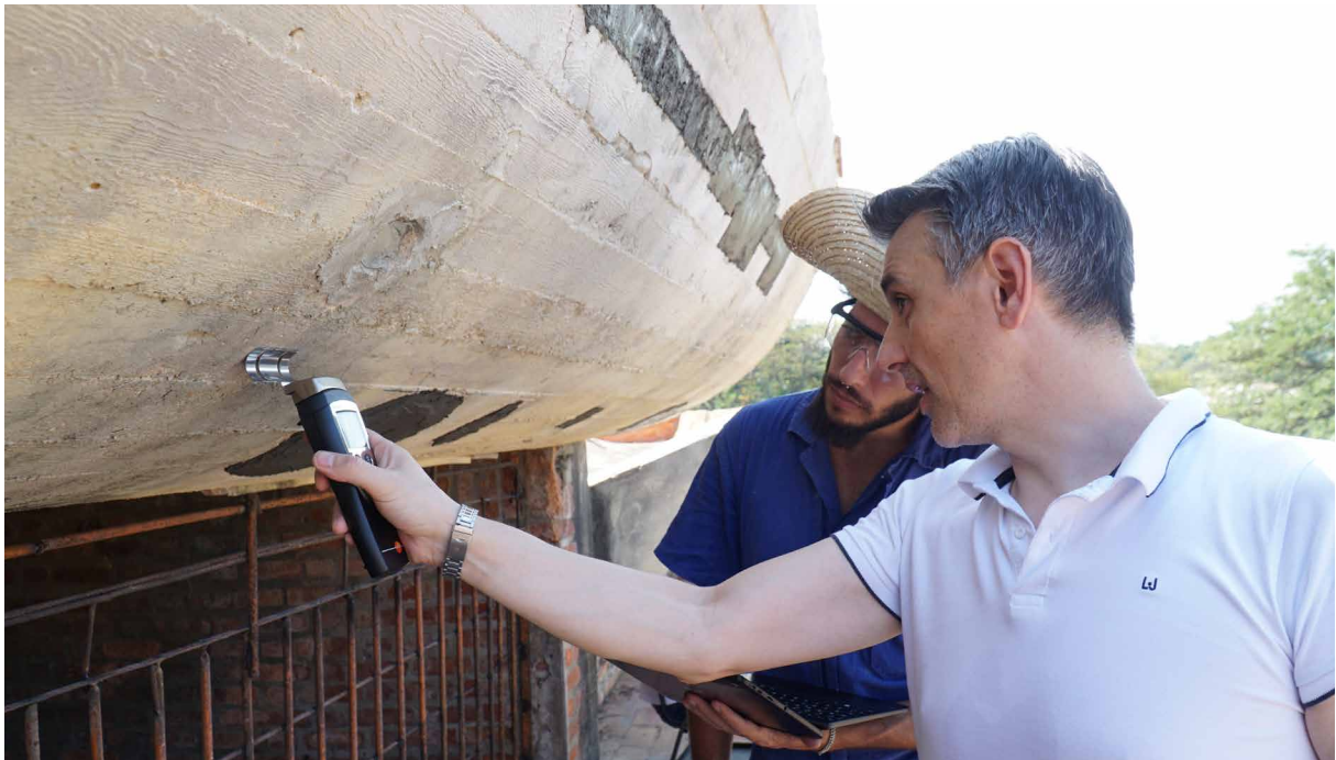
Figura 11 | Detección de humedad superficial (profundidad 3/5 cm aprox.).
