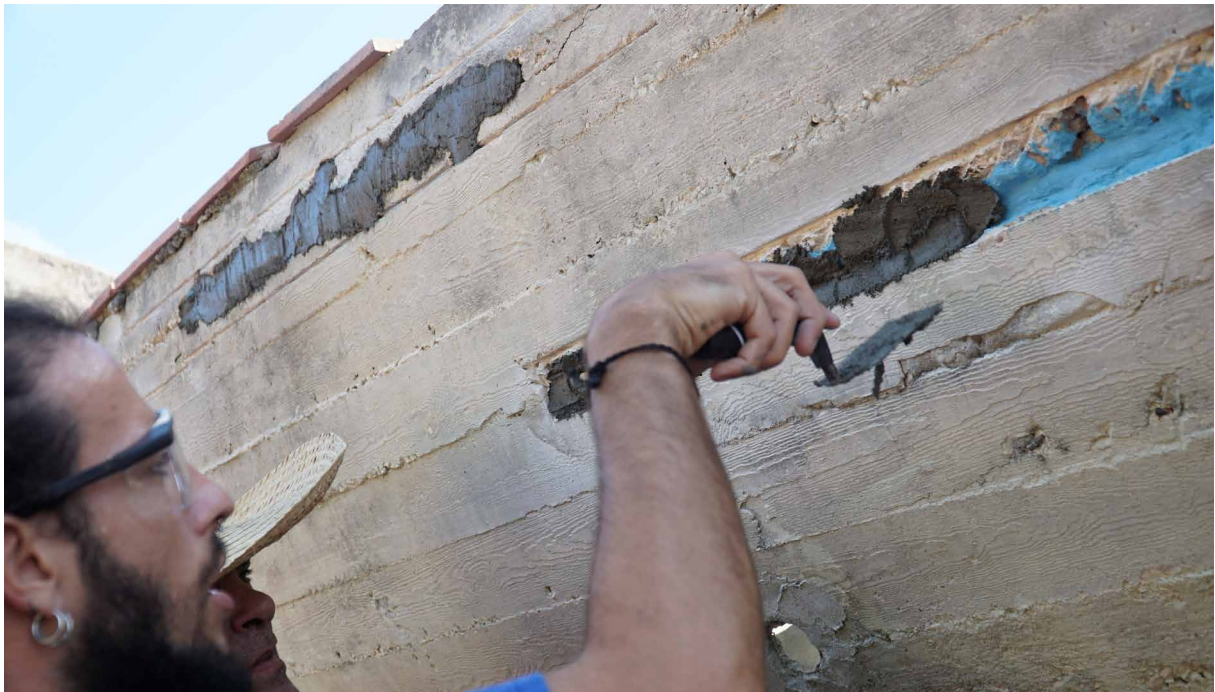
Figura 2 | Aplicación de Mapegrout T60 Mapei (primera capa).
