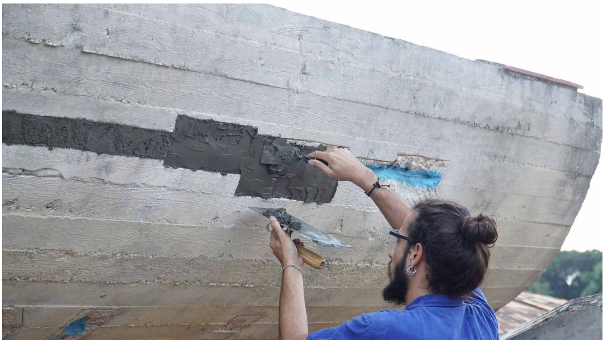
Figura 3 | Aplicación de Mapegrout T60 Mapei (segunda capa).
