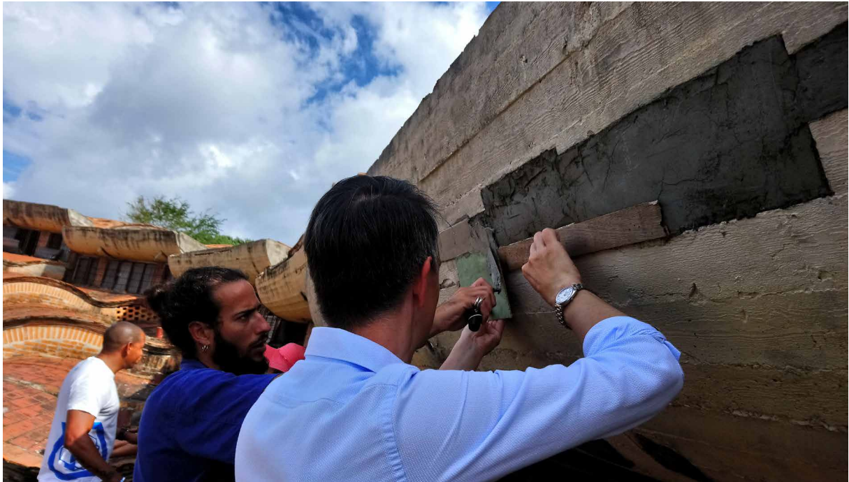
Figura 1 | Aplicación del acabado Mapei PLANITOP FINE FINISH.
