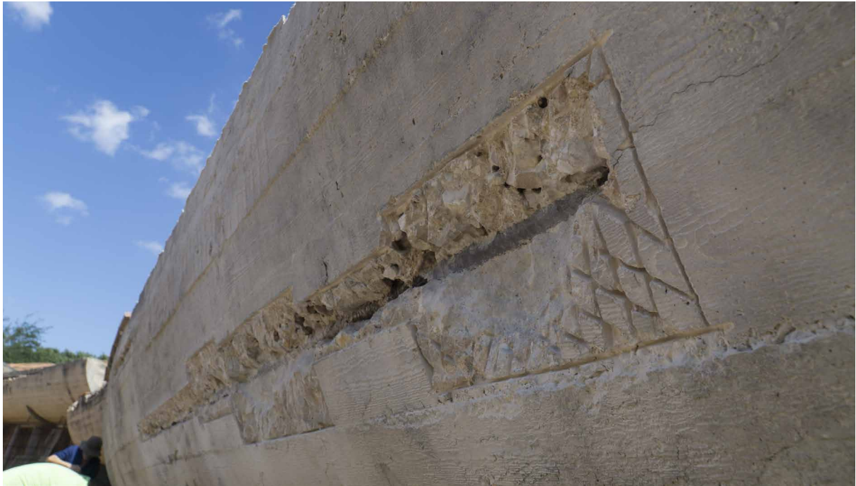
Figura 9 | Cortes de diversas formas geométricas en correspondencia con los hierros expuestos.
