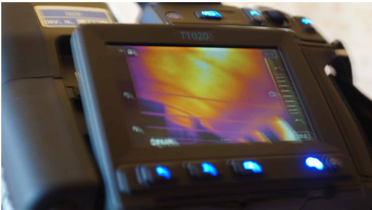
Figura 5 | Imagen termográfica en el BLOQUE 5. Se destaca la presencia de algunos elementos o hierros “tipo costilla” en las bóvedas.
