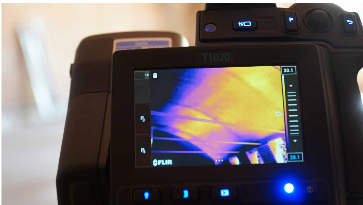
Figura 3 | Imagen termográfica en el BLOQUE 1. Se destaca la presencia de algunos elementos o hierros “tipo costilla” en las bóvedas.
