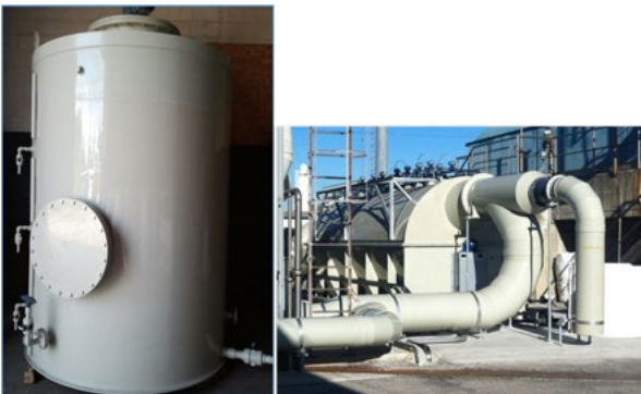
Impianti pilota per l'applicazione di processi innovativi per il trattamento di acque reflue e rifiuti, realizzati all'interno di impianti di depurazione di acque reflue industriali e civili / Pilot-scale plant applying innovative processes for industrial tannery wastewater and waste, developed in industrial and municipal wastewater treatment plants
